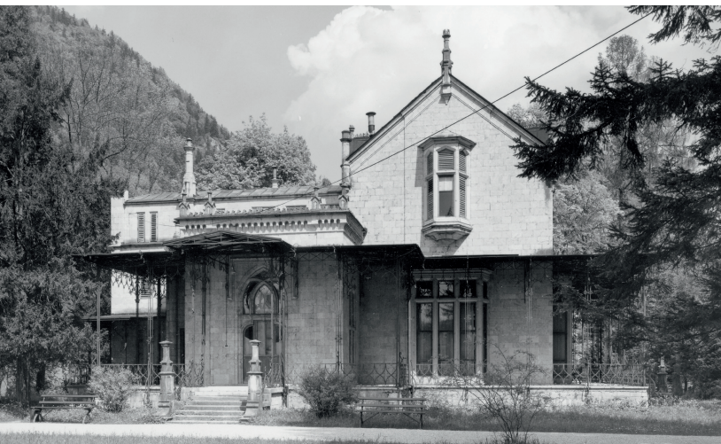
Abb. 5: Archivaufnahme 1975 Südfassade vor Adaptierungs- bzw. Umbauarbeiten
