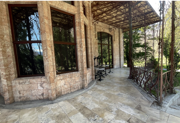
Abb. 3: Detail der Terrasse mit vorhandenen drei Kalkstein-varietäten, am Boden der in den 1970er Jahren hinzugefügte Teuchtlinger Marmor, an der Fassade rosa Traunsee- und grauer Pötschenmarmor
